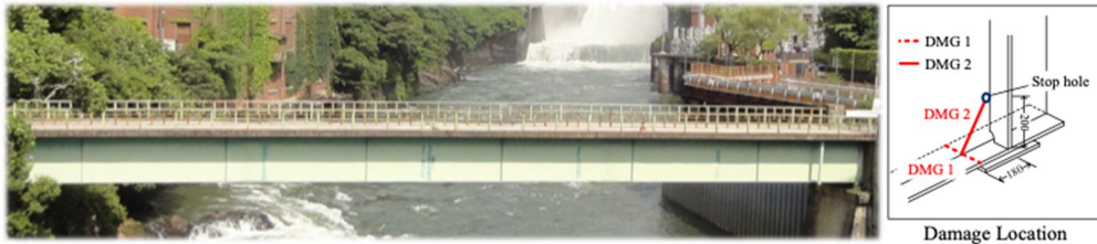
図 4-2-4 対象橋梁とセンサー導入位置および人工損傷
