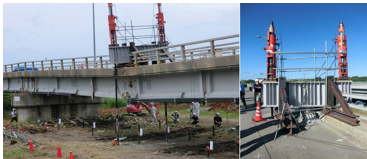
図 4-2-1 対象 PC 橋と破壊実験光景
