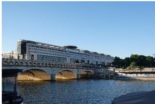
図8 ベルシー橋の外観(遠景)
