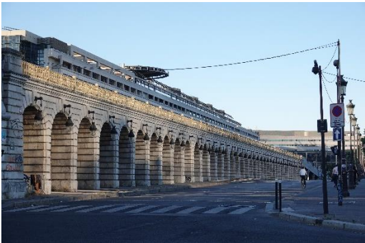
図7 ベルシー橋の外観
