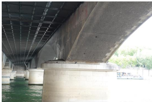
図13 桁下側の外観
