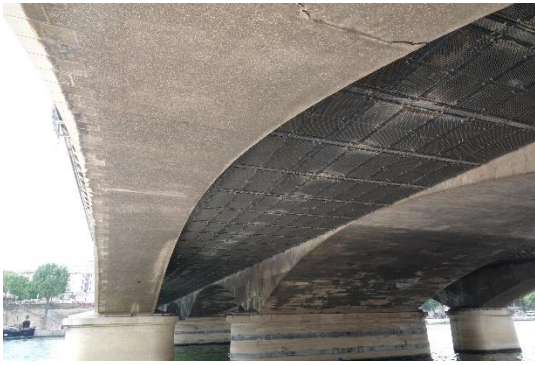
図 14 亀裂の様子
