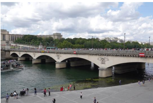
図12 イエナ橋の外観
