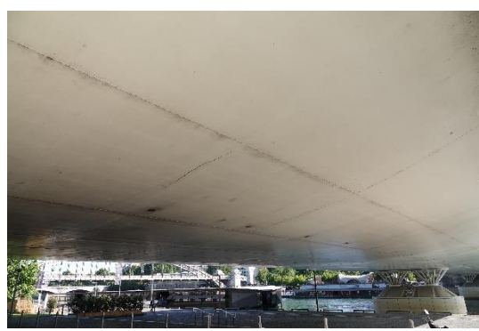
図4 桁下側の外観
